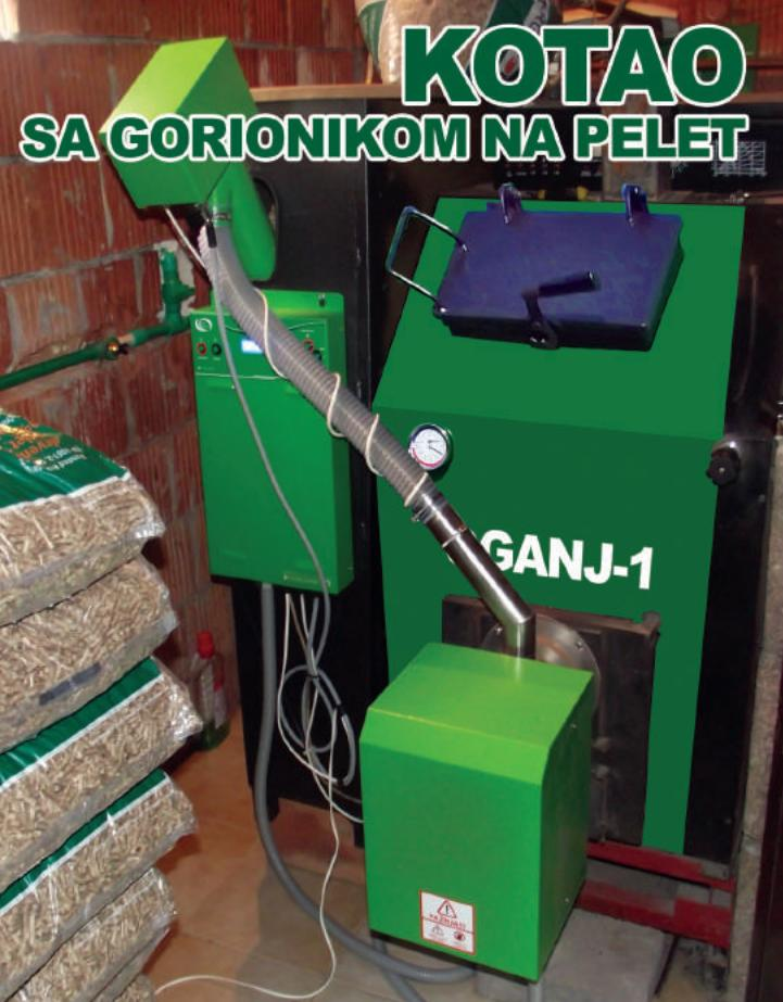
Dna ložišta kotlova izrađena su od kotlovnih cevi evropske marke P235G1TH EN 10027, kroz koje protiče hladna kotlovska voda i hlađi ih, tzv. vodom hlađeni rost.
